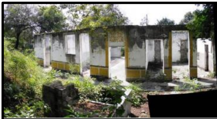
Figura 8. Casa de la Desinfección. Fachada posterior costado oriental.
