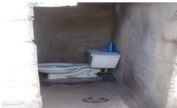
Fotografía N° 2: Baño de la vivienda
