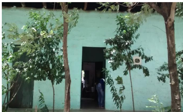
Fotografía N° 1: Fachada Principal de la vivienda
