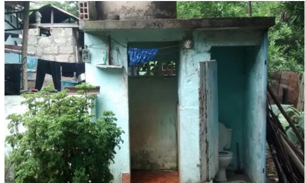
Fotografía N° 2: Baño de la vivienda
