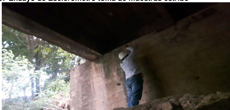
Ilustración 37 Ensayo de Esclerómetro toma de muestras estribo
