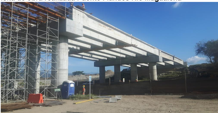
Ilustración 27 Visita de obra realizada Puente Flandes Rio Magdalena
