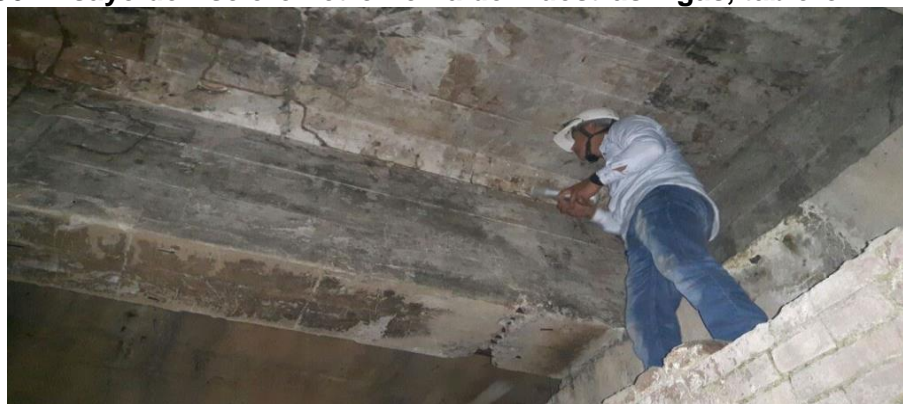
Ilustración 36 Ensayo de Esclerómetro Toma de muestras vigas, tablero
