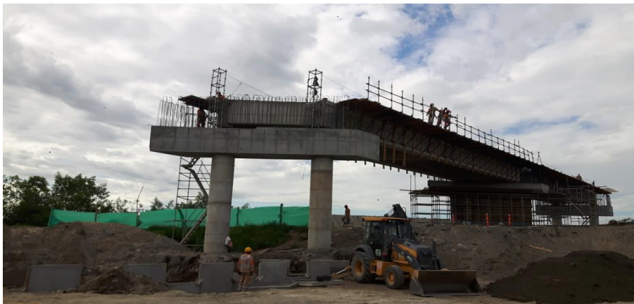
Ilustración 26 Visita de obra realizada Puente intersección Flandes.
