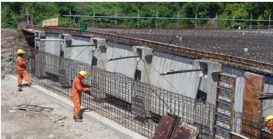
Ilustración 28 Visita de obra realizada Puente Flandes K2+750
