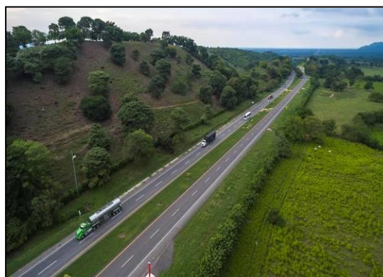
( Se Observa la doble calzada Aguachica – la Mata Proyecto Ruta del Sol Sector 2).
