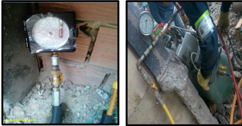
IMAGEN No 8: INSPECCION Y ENSAYO
