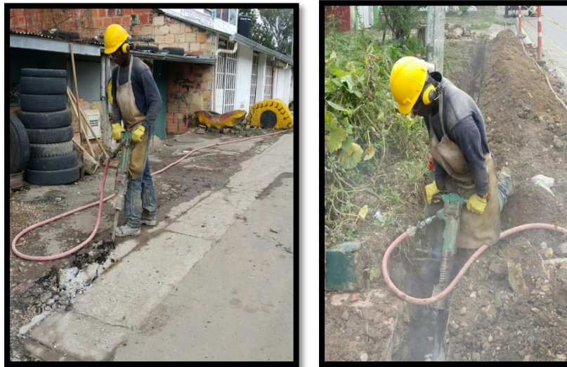
IMAGEN No 1: ACTIVIDAD DE ROTURA
