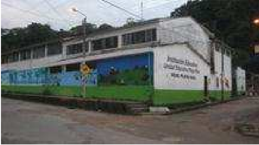
Infraestructura de la sede Principal
