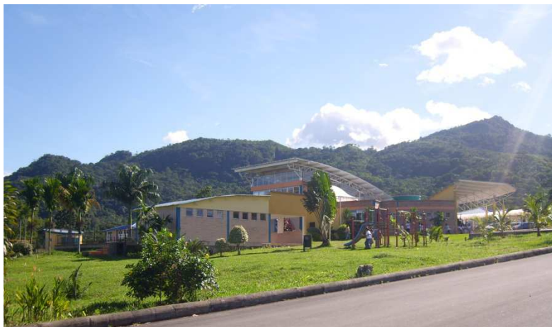
Infraestructura de la sede Principal
