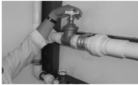
Figura 41. Válvula 1 línea superior.
