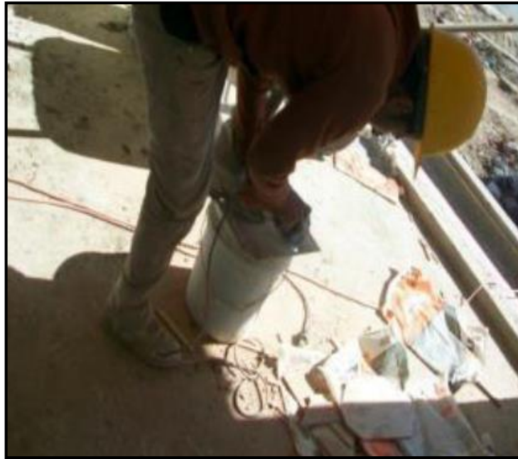
Figura 52 Obrero cortando material
