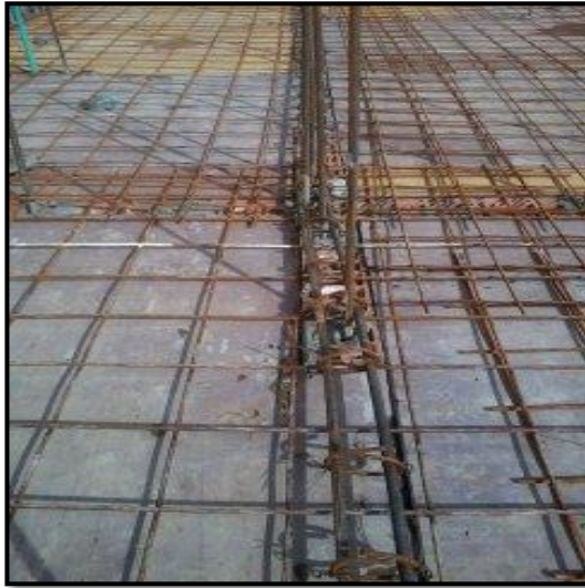
Figura 5 Proceso Constructivo Estructura
