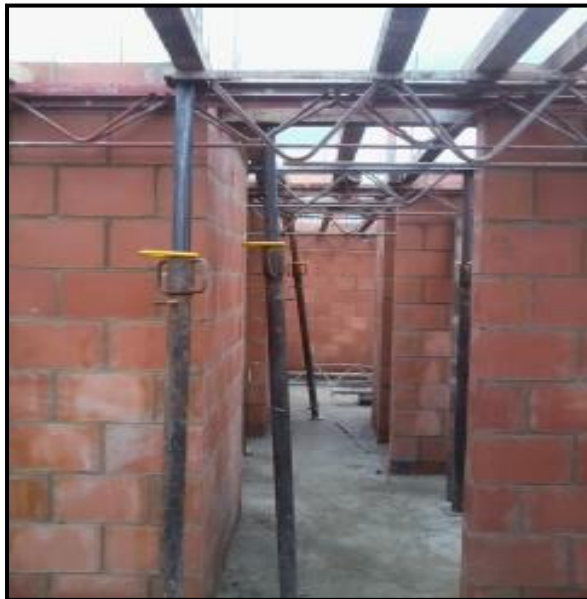
Figura 4 Proceso Constructivo Estructura
