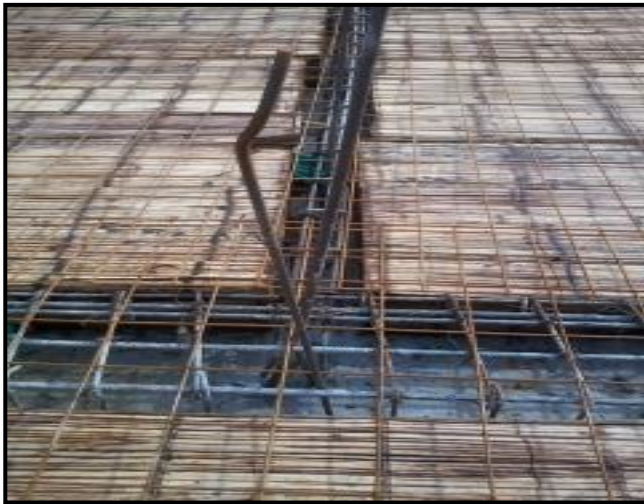
Figura 7 Proceso Constructivo Estructura
