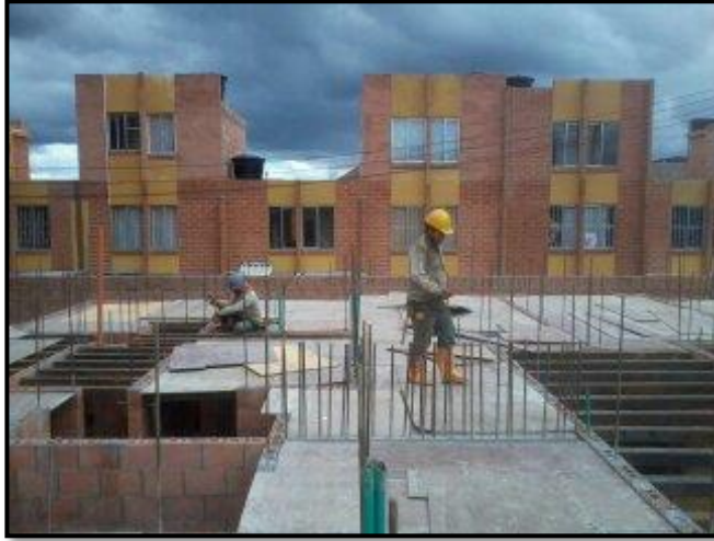
Figura 3 Proceso Constructivo Estructura
