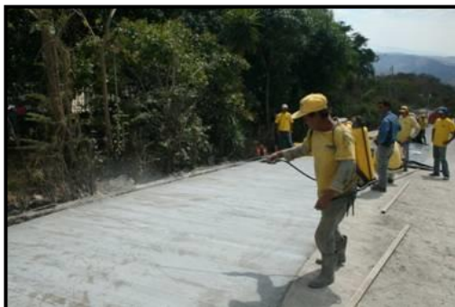
Figura 9 Proceso Constructivo Estructura
