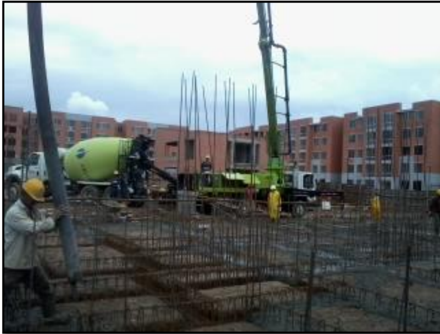
Figura 8 Proceso Constructivo Estructura
