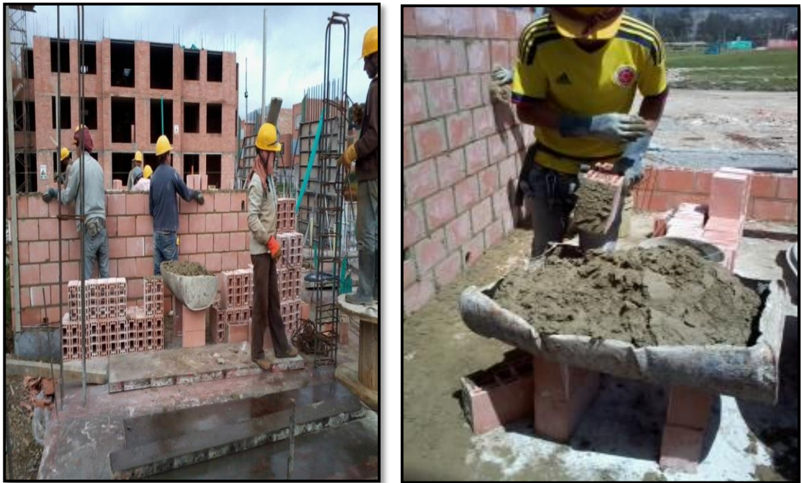
Figura 32 Colocación de material
