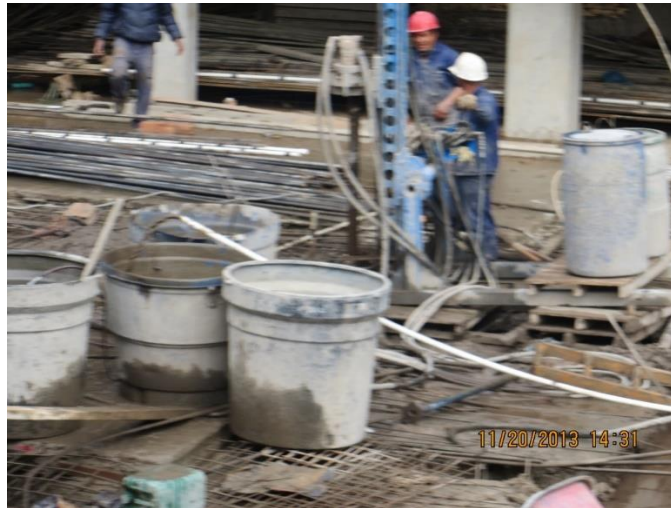
Figura 23. Perforación y extracción de lodos.
