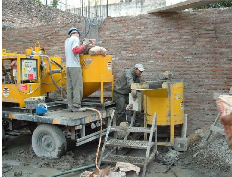
Figura 26. Equipos que fueron utilizados para la inyección y fabricación de la lechada de micropilotes.
