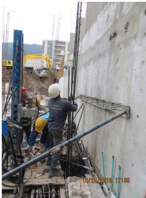
Figura 24. Instalación de la armadura.
