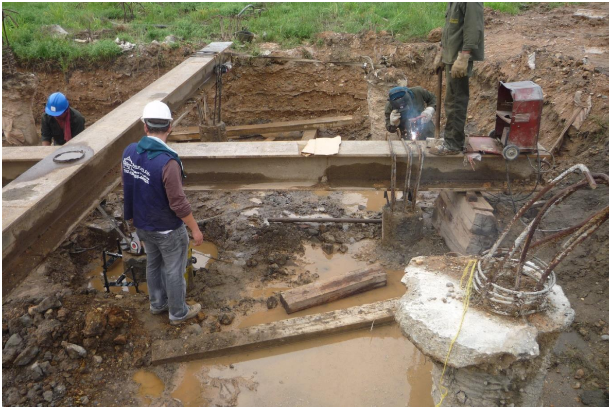
Figura 21. Construcciones estructura para pruebas de carga en micro pilotes
