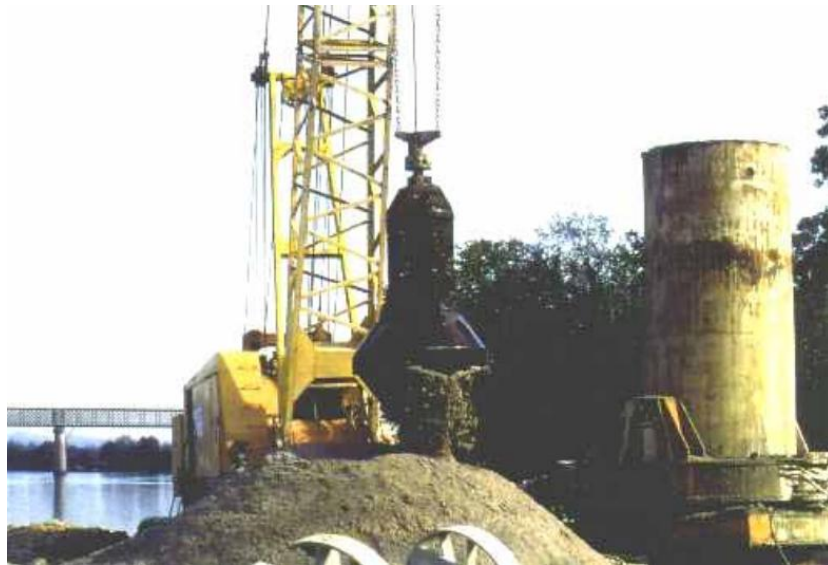
Figura 14, Pozo Empotrado, Procedimientos Constructivos, Excavación con cuchara de almeja (Hurtado, 2008)
