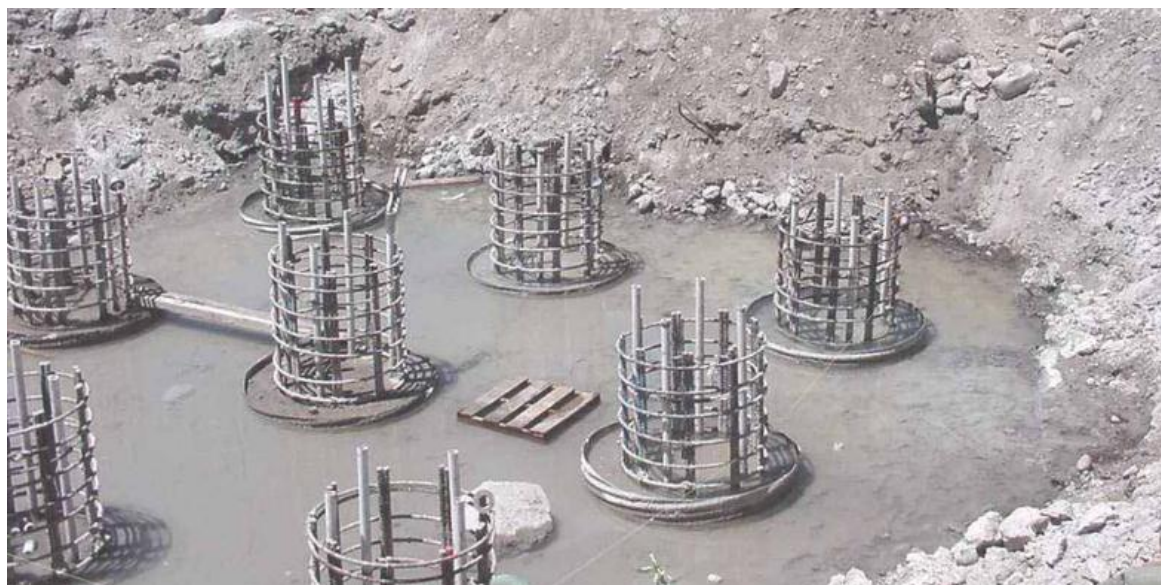
Figura 18, Pozo Empotrado, Procedimientos Constructivos, Columnas de cimentación terminadas (Hurtado, 2008)
