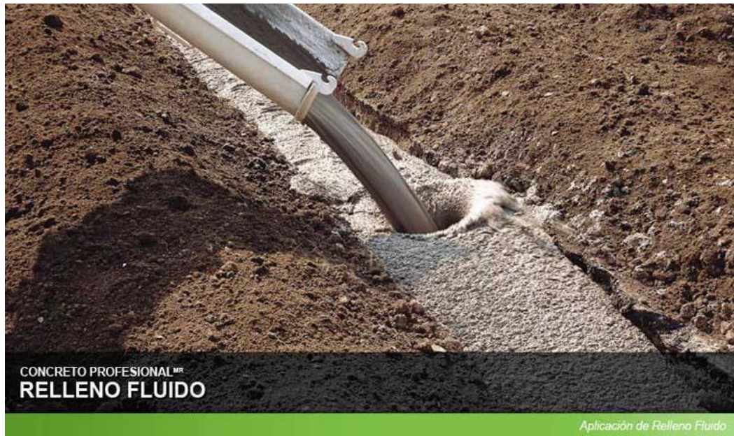
Figura 3, Vertimiento de relleno fluido
