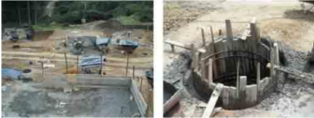
Figura 5, Vaciado del concreto en el primer anillo. (Constructor Civil, 2010), Colocando los postes para instalar el carretel.
