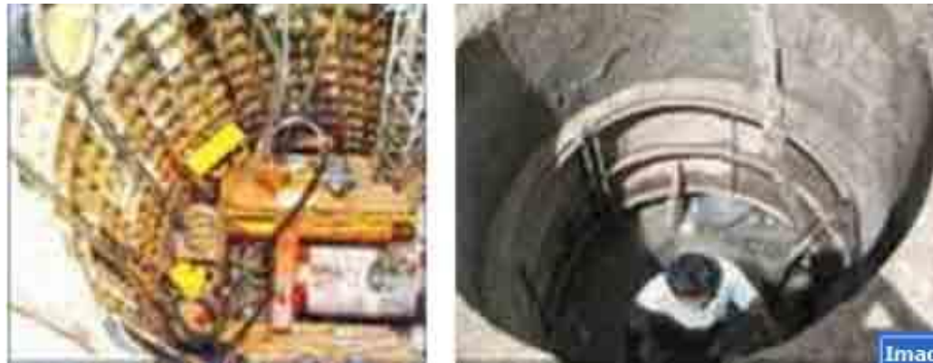
Figura 6, Instalación de los postes para el carrete. (Constructor Civil, 2010), Asegurando el carretel de su eje.
