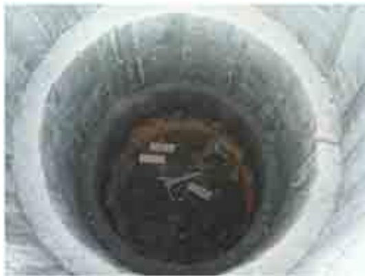
Figura 9, Vaciado de cada anillo (segundo anillo) (Constructor Civil, 2010)
