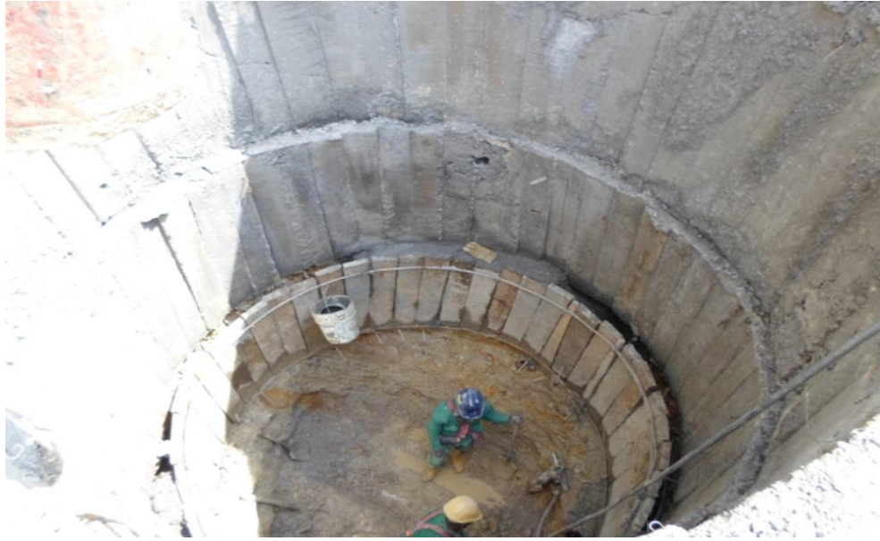
Figura 26, fundida anillo en el Relleno con Concreto de Alta Resistencia.
