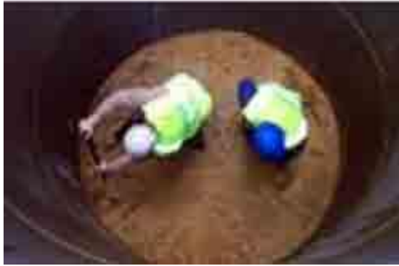
Figura 8, Excavación de cada anillo (segundo). (Constructor Civil, 2010), Vaciado del segundo anillo.
