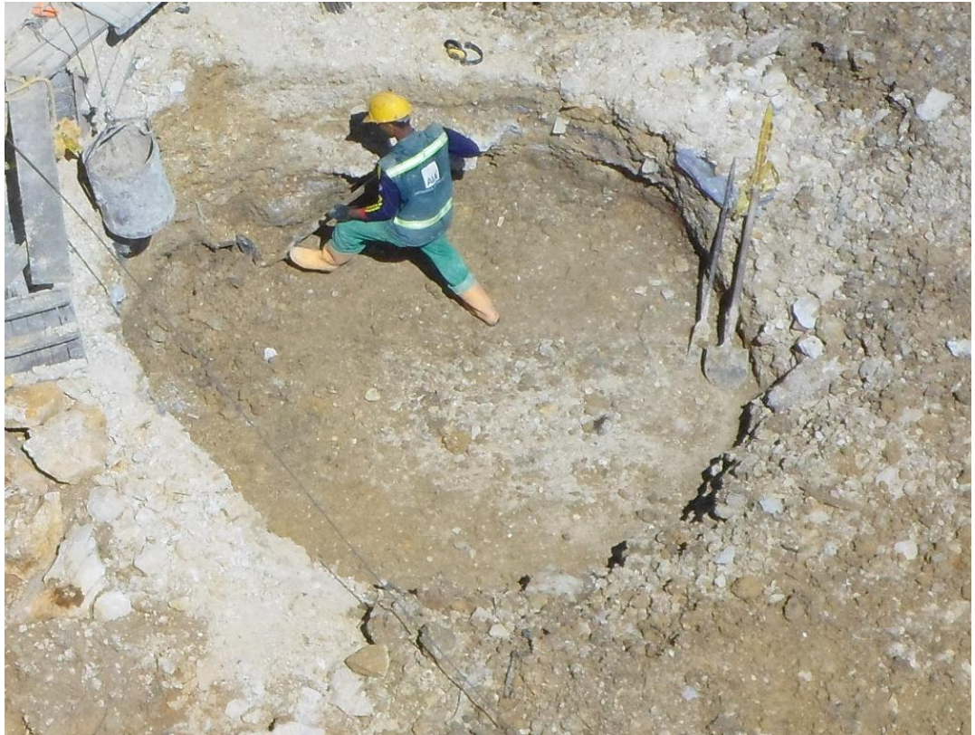
Figura 23, perfilada pared base, en el Relleno con Concreto de Alta Resistencia..
