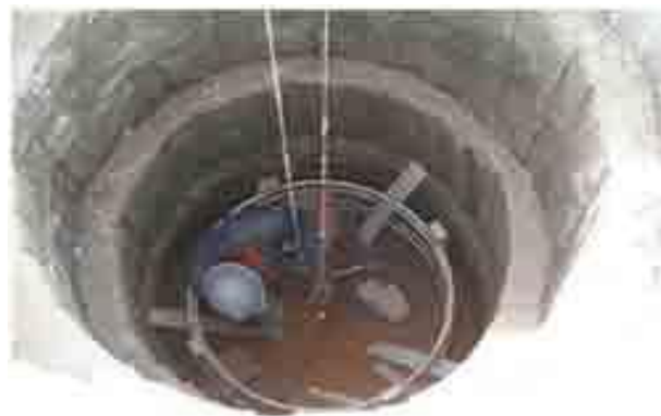
Figura 7, Asegurado del carrete al eje. (Constructor Civil, 2010), Excavar el segundo anillo.
