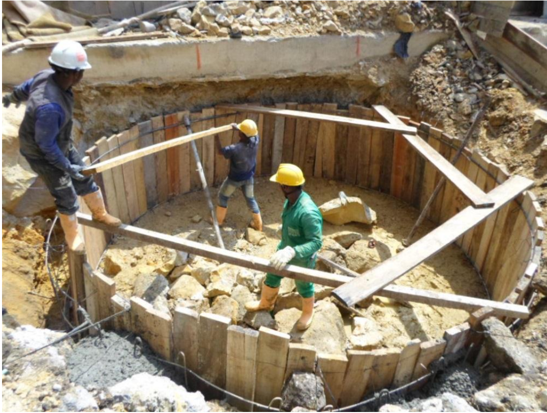
Figura 25, Encofrado para el Relleno con Concreto de Alta Resistencia.
