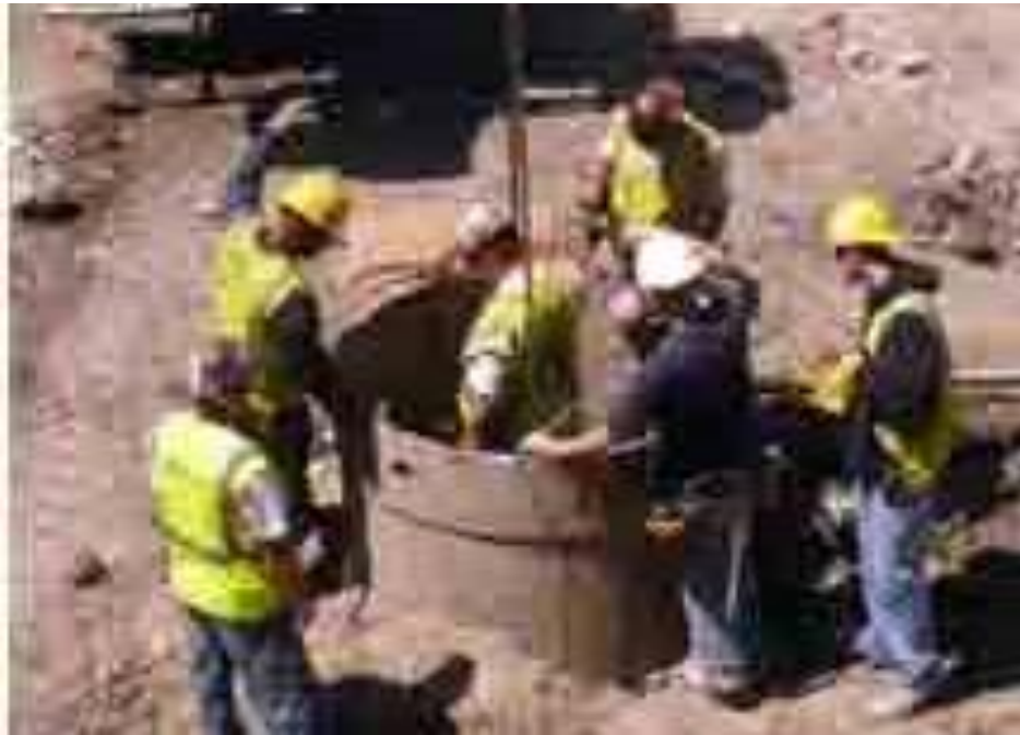
Figura 11, preparación de equipo para excavación a profundidad (Constructor Civil, 2010)
