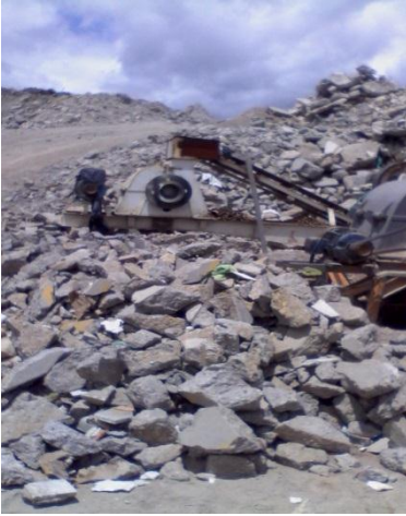
Figura. 29. Zona de almacenamiento de escombros de concreto.
