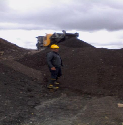
Figura. 27. Planta de tratamiento de producción de ACR.
