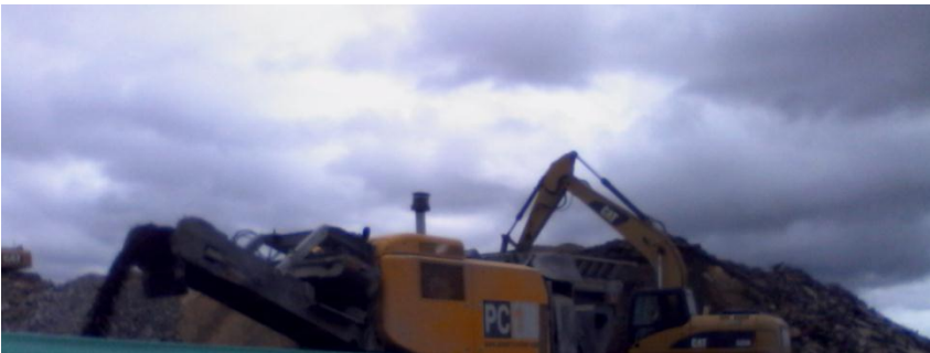
Figura. 30. Trituración del concreto.
