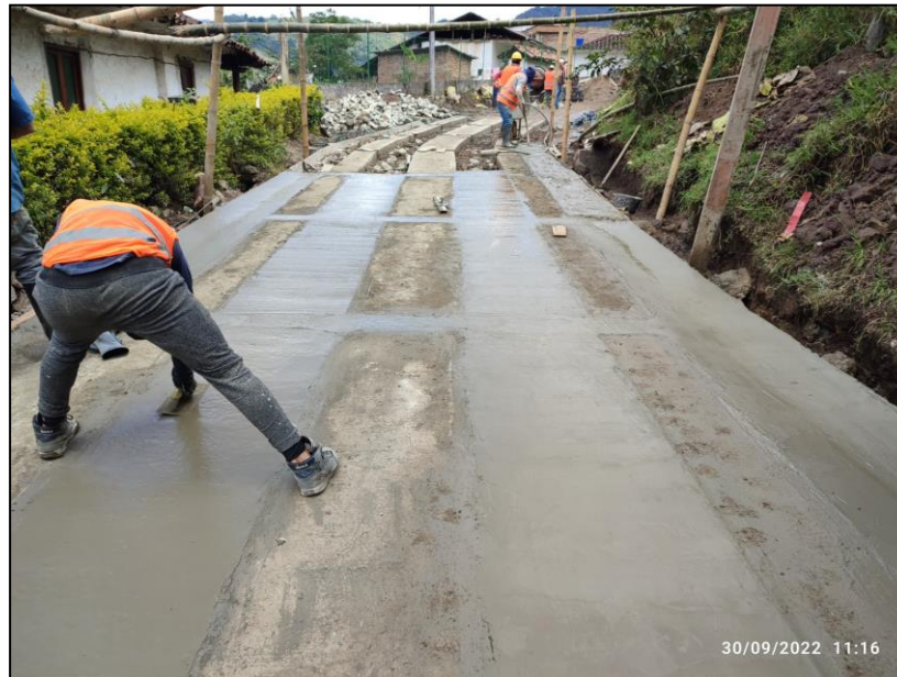
Figura 10: Acabado de concreto reforzado con el uso de llana
