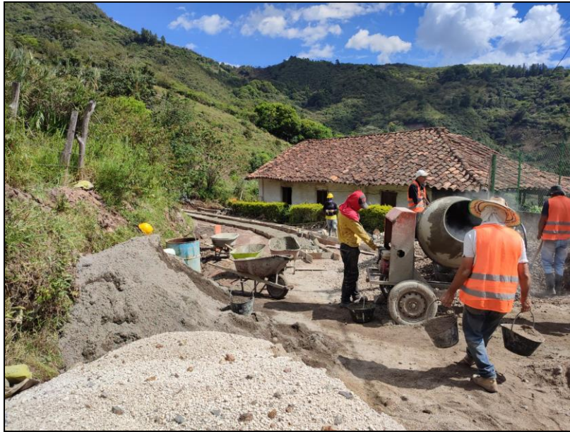
Figura 7: Proceso de preparación del concreto reforzado
