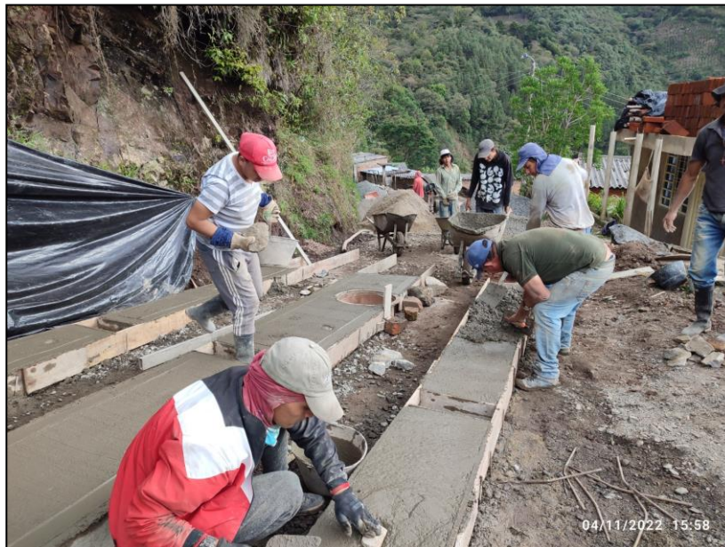
Figura 9: Compactación manual del concreto reforzado
