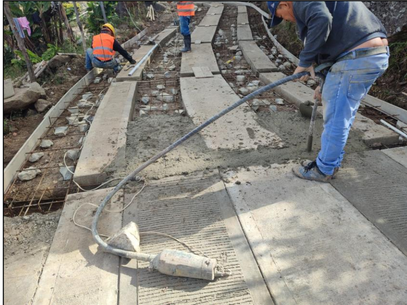
Figura 8: Vibración de concreto mediante uso de vibrador de aguja
