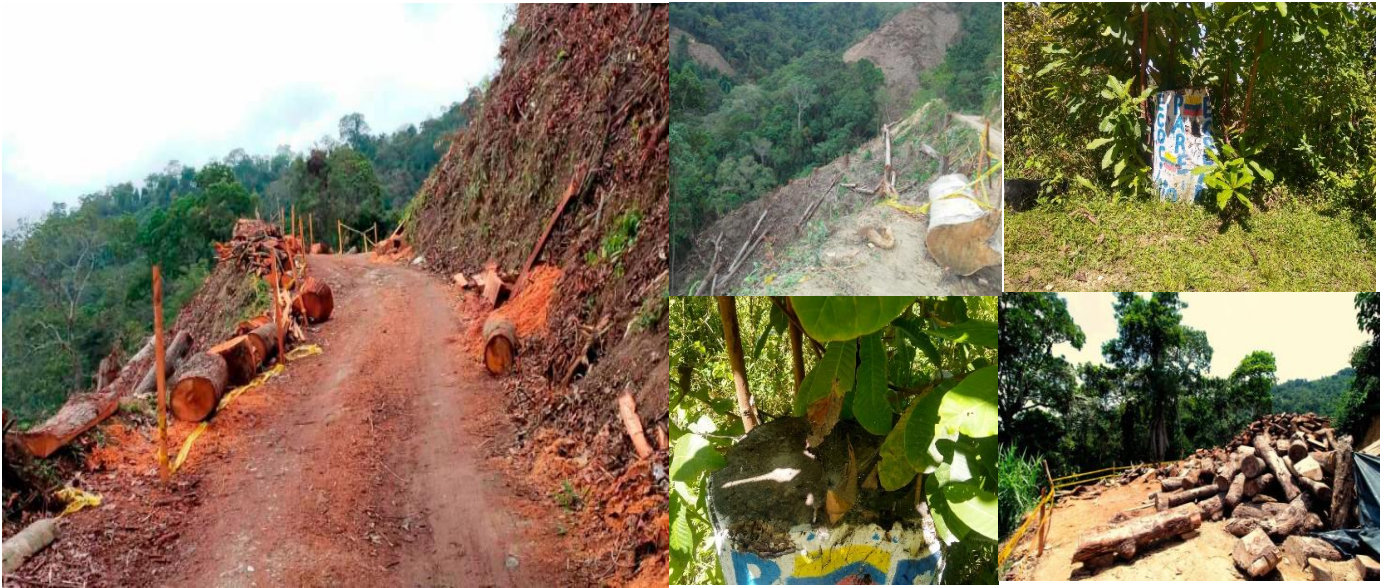
Imagen 2. Ecocidio del bosque de la vereda Casiano debido al inicio de la construcción de la conectante C1 – C2.
