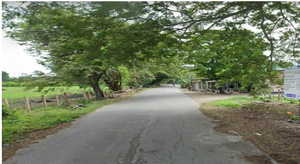
Figura 16. Acceso instalaciones del proyecto.
