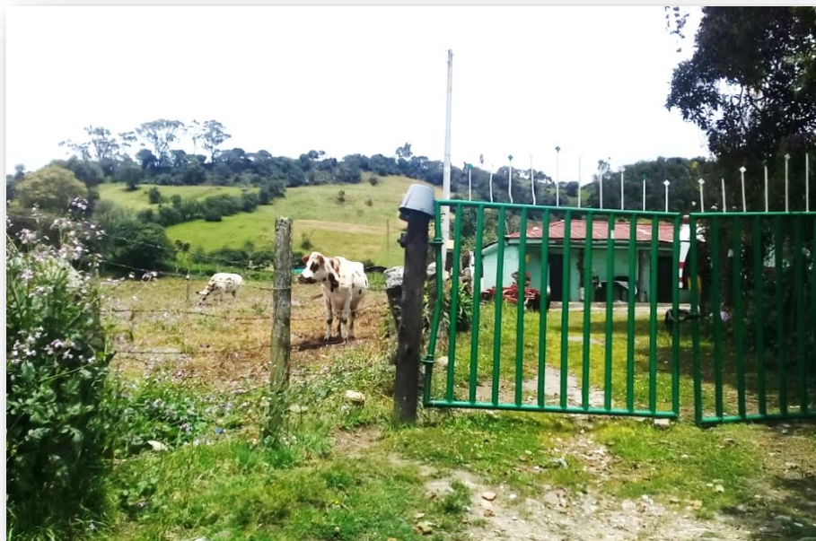
Figura 2. Casa vereda Olarte por carretera, septiembre 2021.
