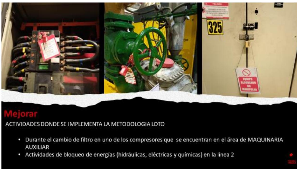
Figura N°19 Implementación de la metodología Loto en actividades de mantenimiento dentro de la planta- área de maquinaria auxiliar. (Elaboración propia)
