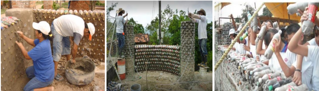
Figura 19 Mampostería en Botellas Pet: ancho muto 30 a 32 cm.
