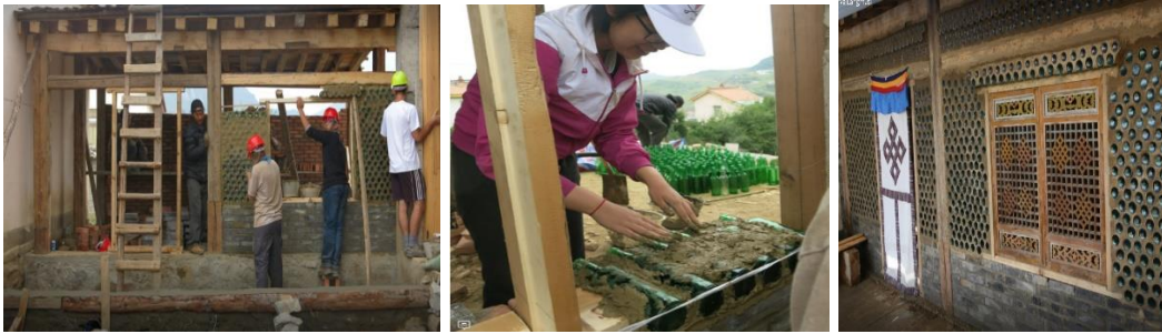
Figura 21 Mampostería en Botellas de vidrio
