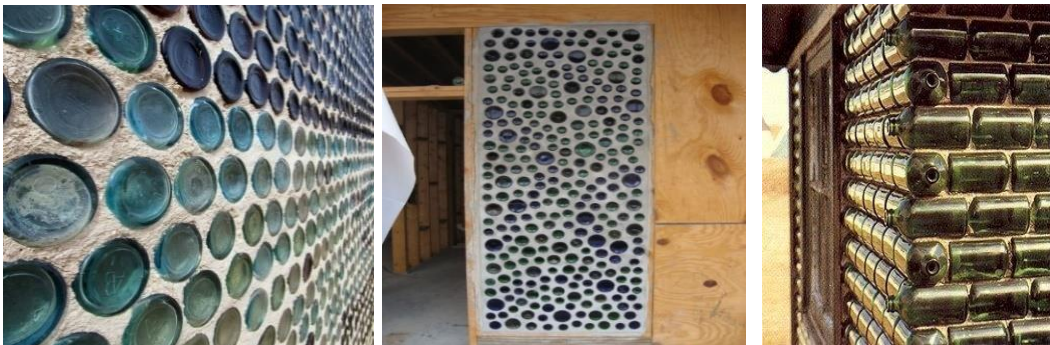
Figura 20 Mampostería en Botellas de vidrio
