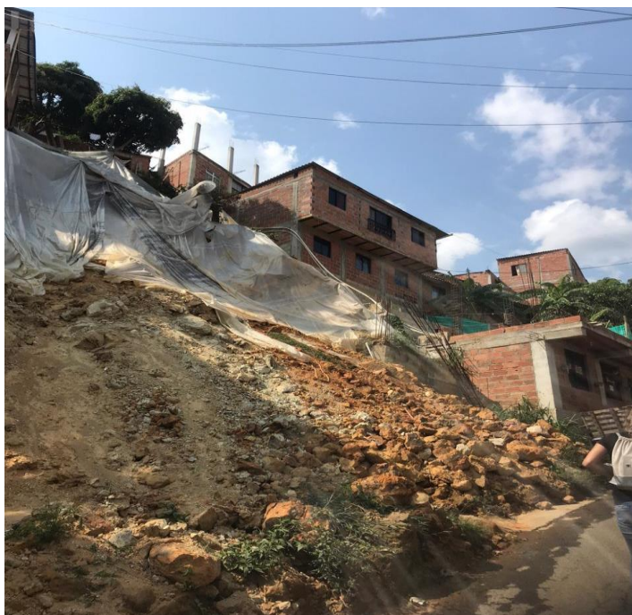
Anexos 1. Fotografía de Luisa Naranjo. (Bello, 2020). Deslizamiento de tierra en el asentamiento informal Brisas del Norte. Niquia Camacol, Bello Antioquia
