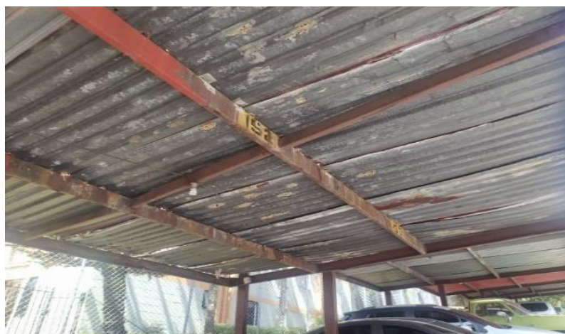
Techo del parqueadero
