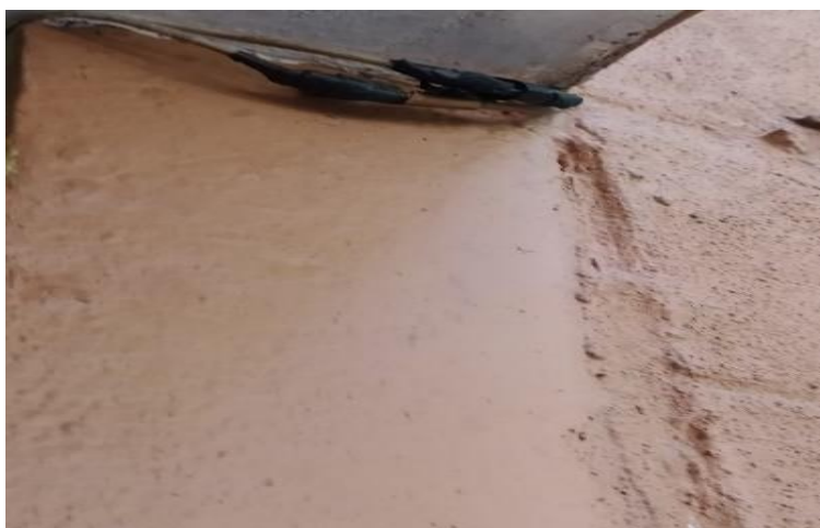
Cables eléctricos en mal estado
