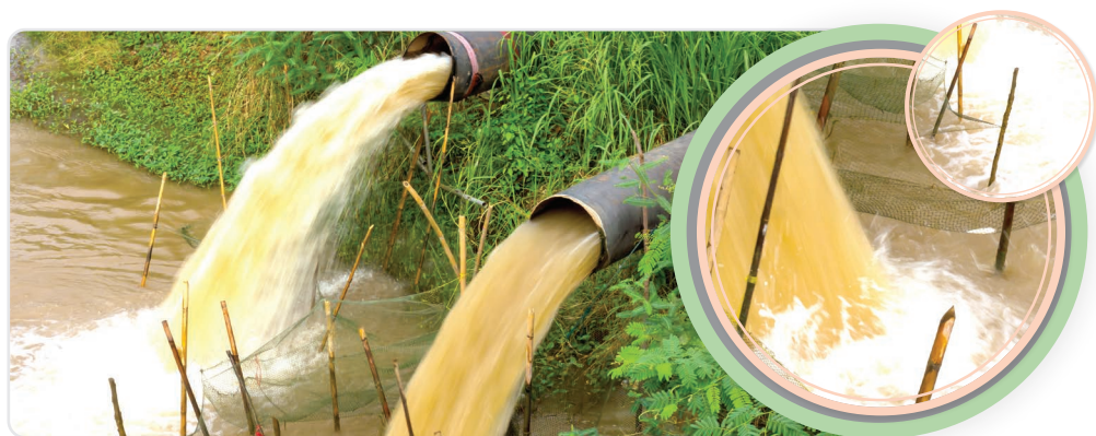
Figura 19.3 Vertido de agua de las alcantarillas en la corriente de un río
