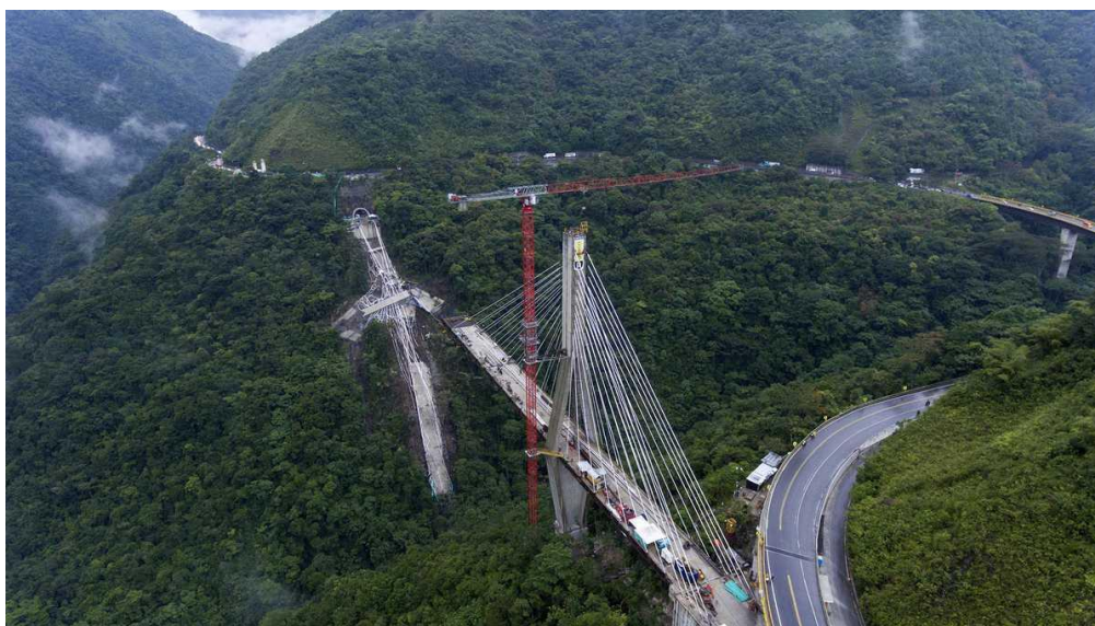
Fotografía 2. Momentos después del colapso del puente.
