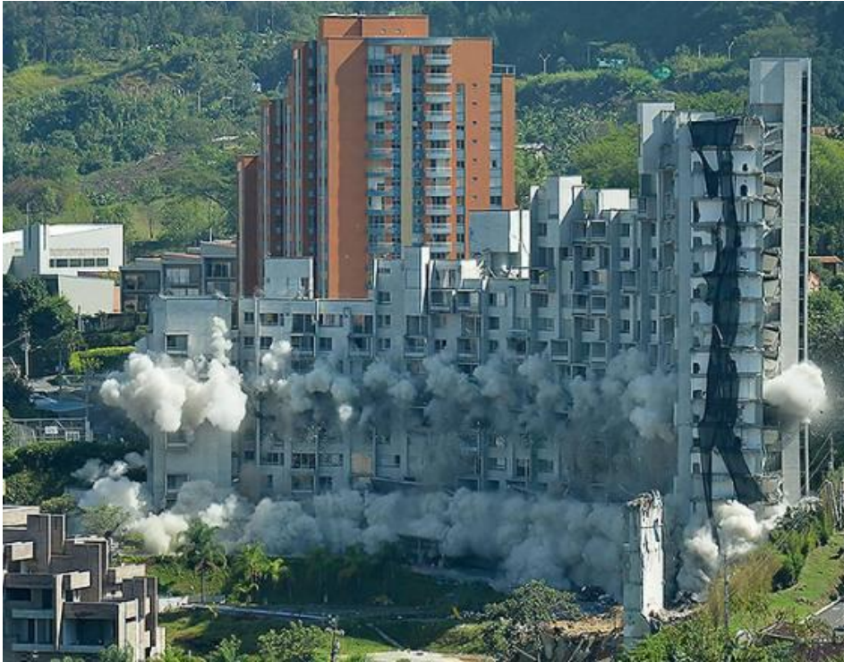
Fotografía 1. Implosión de la estructura del edificio.
