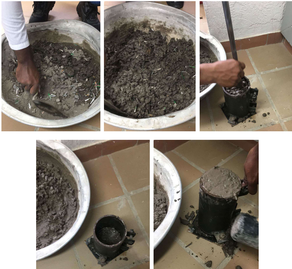
Anexo 3. Vaciando el concreto con 3% de adición de fibras de aluminio, en el cilindro.
