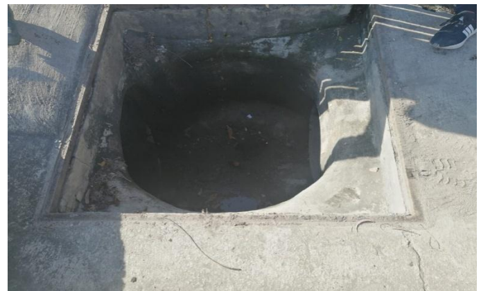
Ilustración 20 INSPECCION DEL SUMIDERO FINAL FUENTE: AUTOR PROPIO
