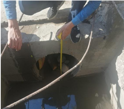
Ilustración 25 INSPECCION VISUAL SUMIDERO FUENTE: AUTOR PROPIO
