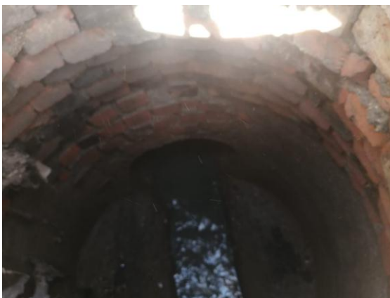
Ilustración 19 DIAGNOSTICO VISUAL POZO DE INSPECCION FUENTE: AUTOR PROPIO
