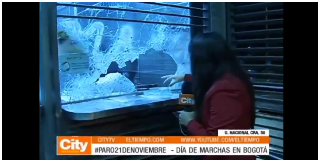
Imagen 5. Daños a estaciones de Transmilenio en Bogotá (City noticias, 2019)
