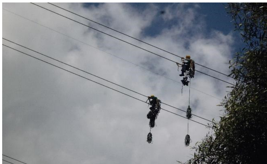
Ilustración 3 Personal realizando mantenimiento, Elaboración Propia, 2020
