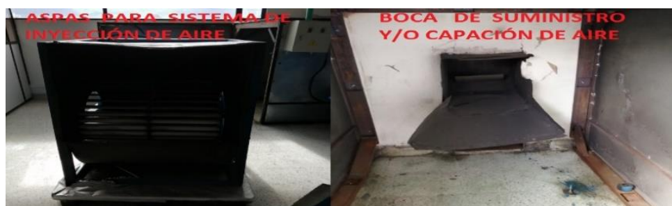
Figura 14. Inspección del sistema de inyección y extracción de aire
