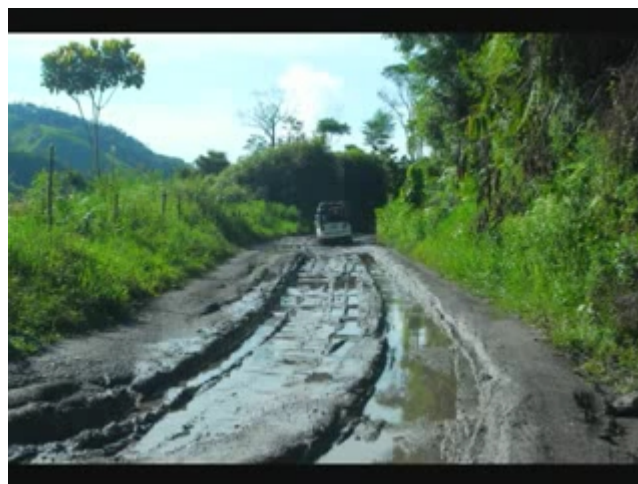
Figura 3. Foto carretera. Vía a San Diego (Samaná, Caldas)
